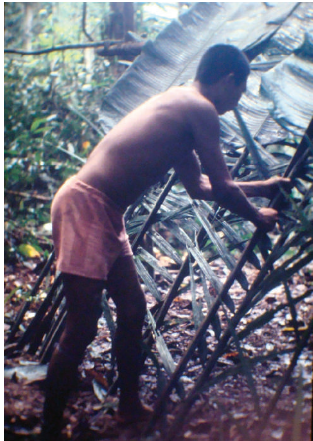
Figura 3. Pero coloca hojas de seje como base del techo de un campamento (Foto: Gabriel Cabrera Becerra).
